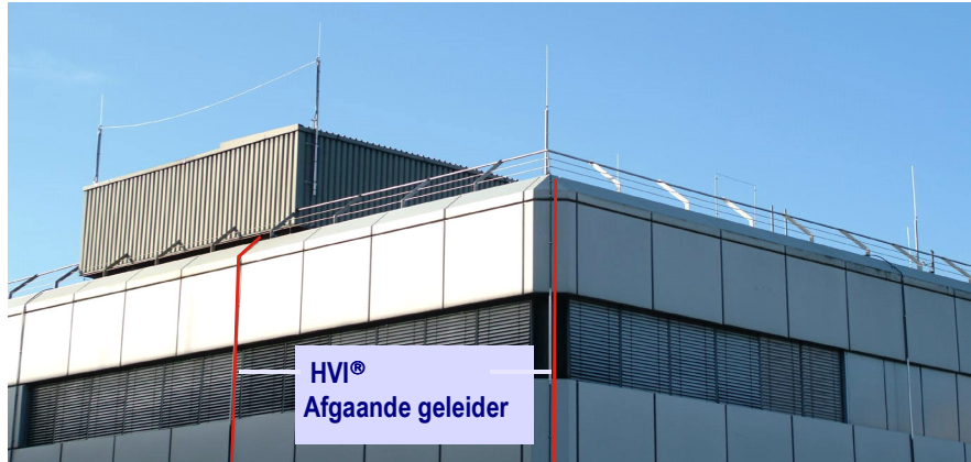
Fig. 7: Opvanginrichting met kabeloverspanning en geïsoleerde geleider
