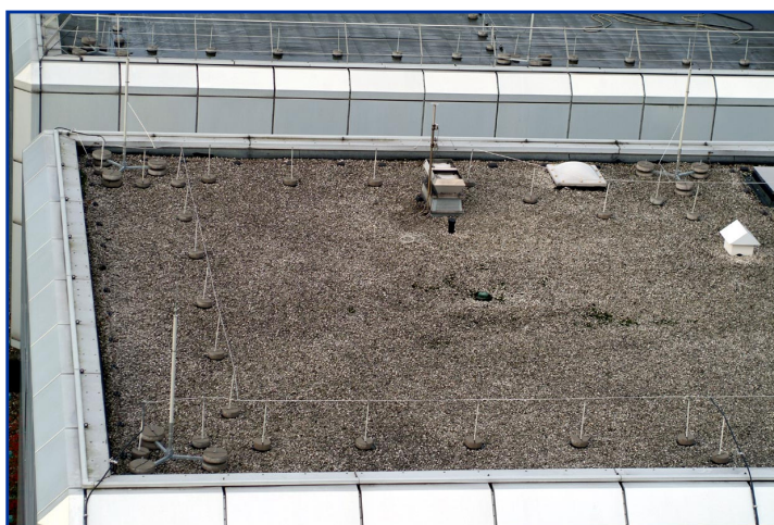
Fig 6b: opvangstang, opstaande ringleiding met aansluiting aan geïsoleerde geleider
